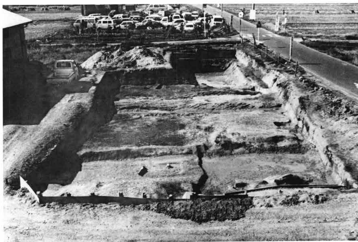
(2) Bトレンチ全景(東から)
