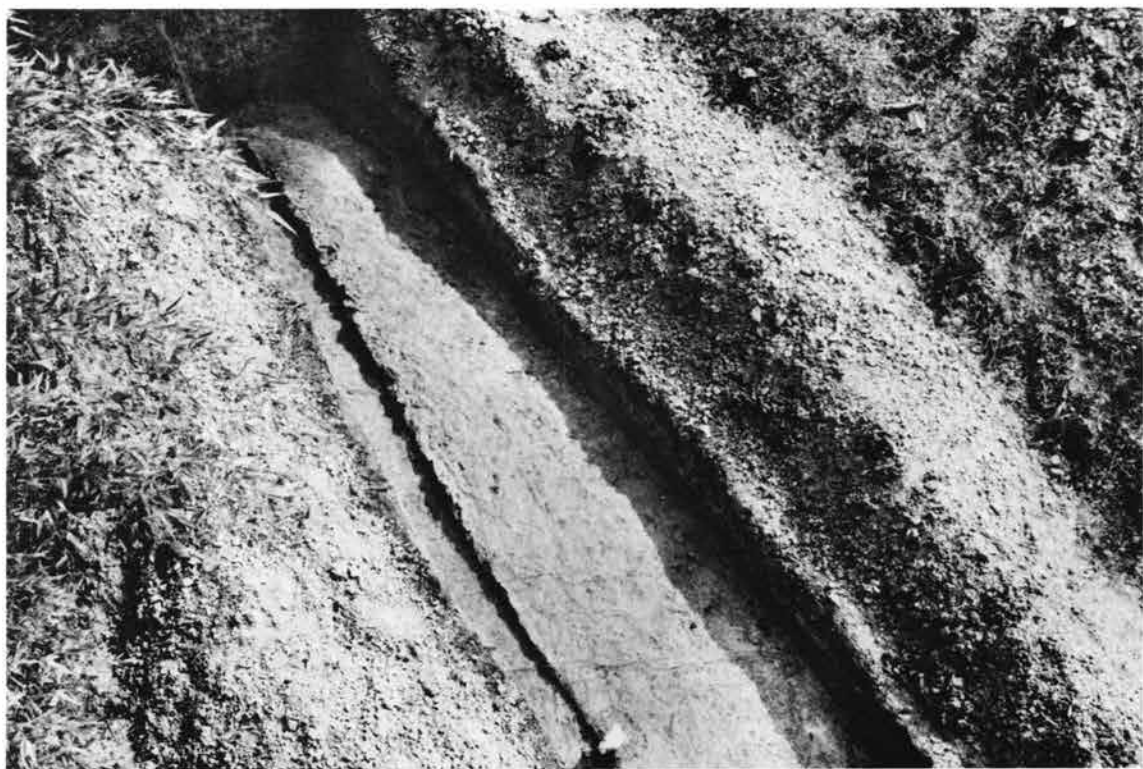
(1) Cトレンチ掘削状況(北から)
