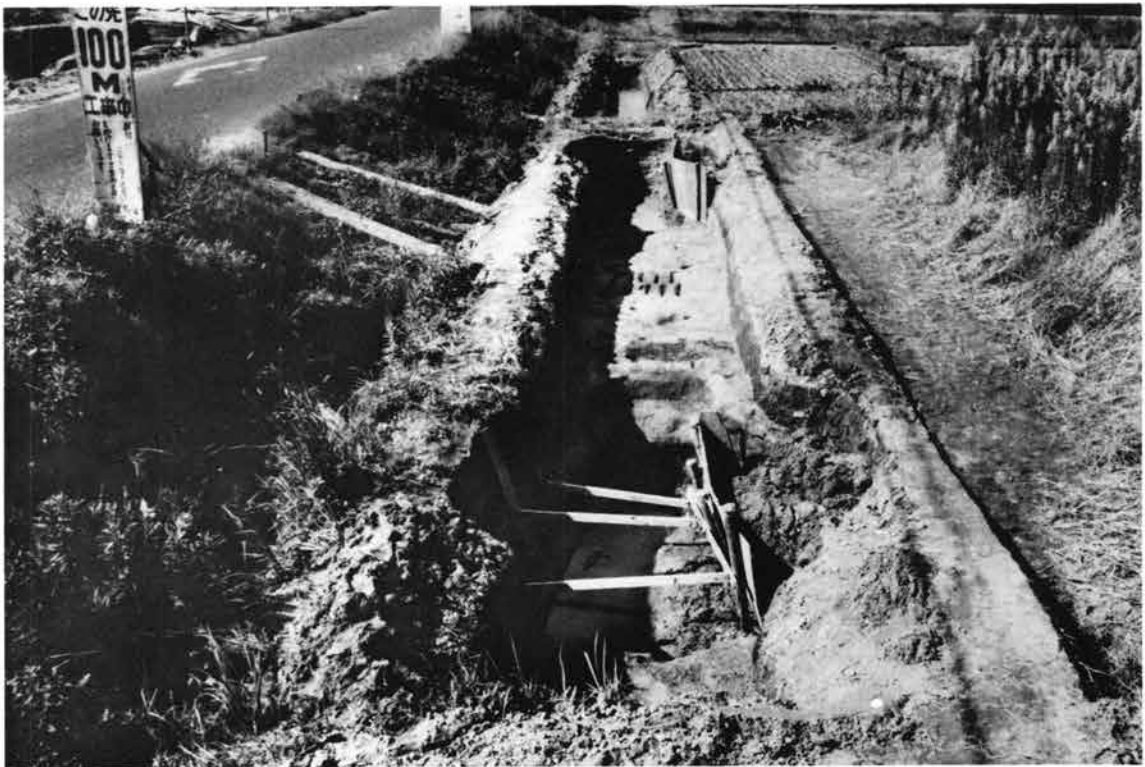
(2) Dトレンチ全景 (東から)
