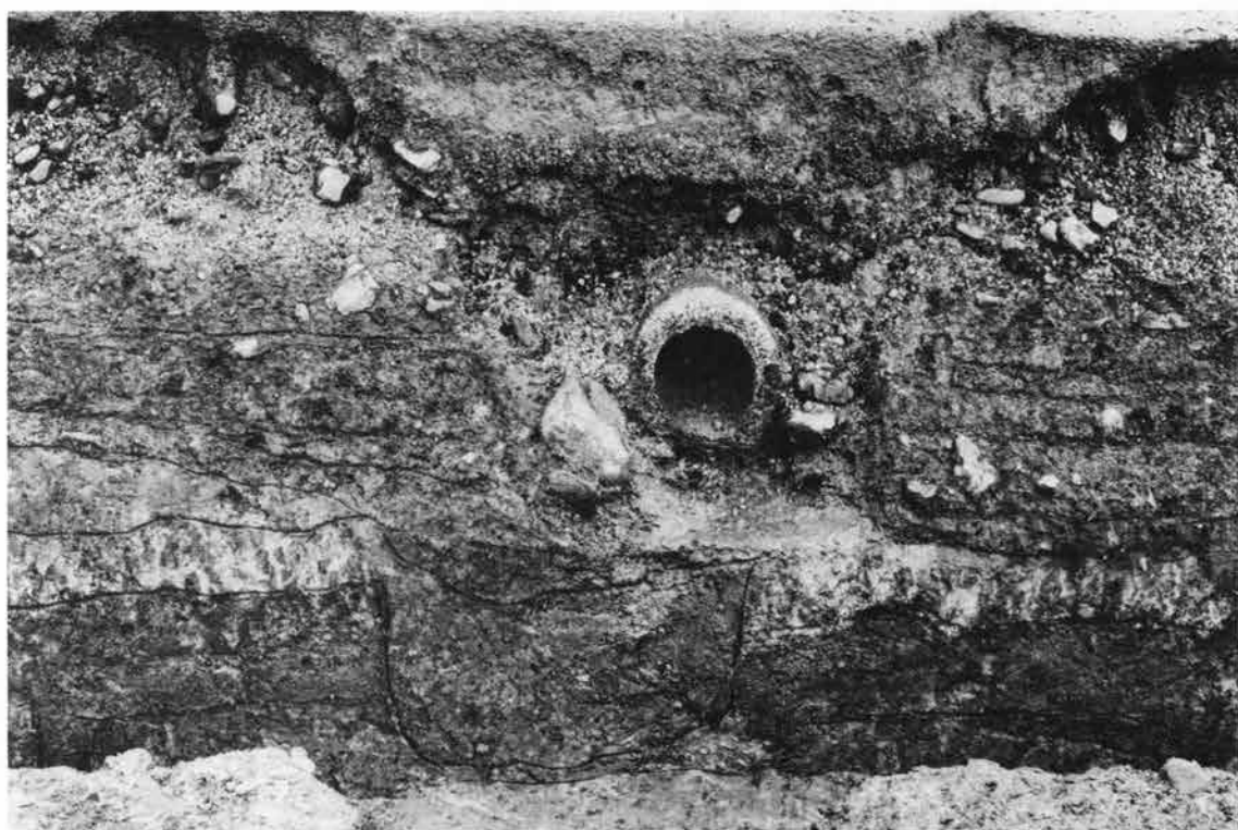
(2) 南側壁断面 上：グラウンド排水路 下：素掘溝 (S D01)
