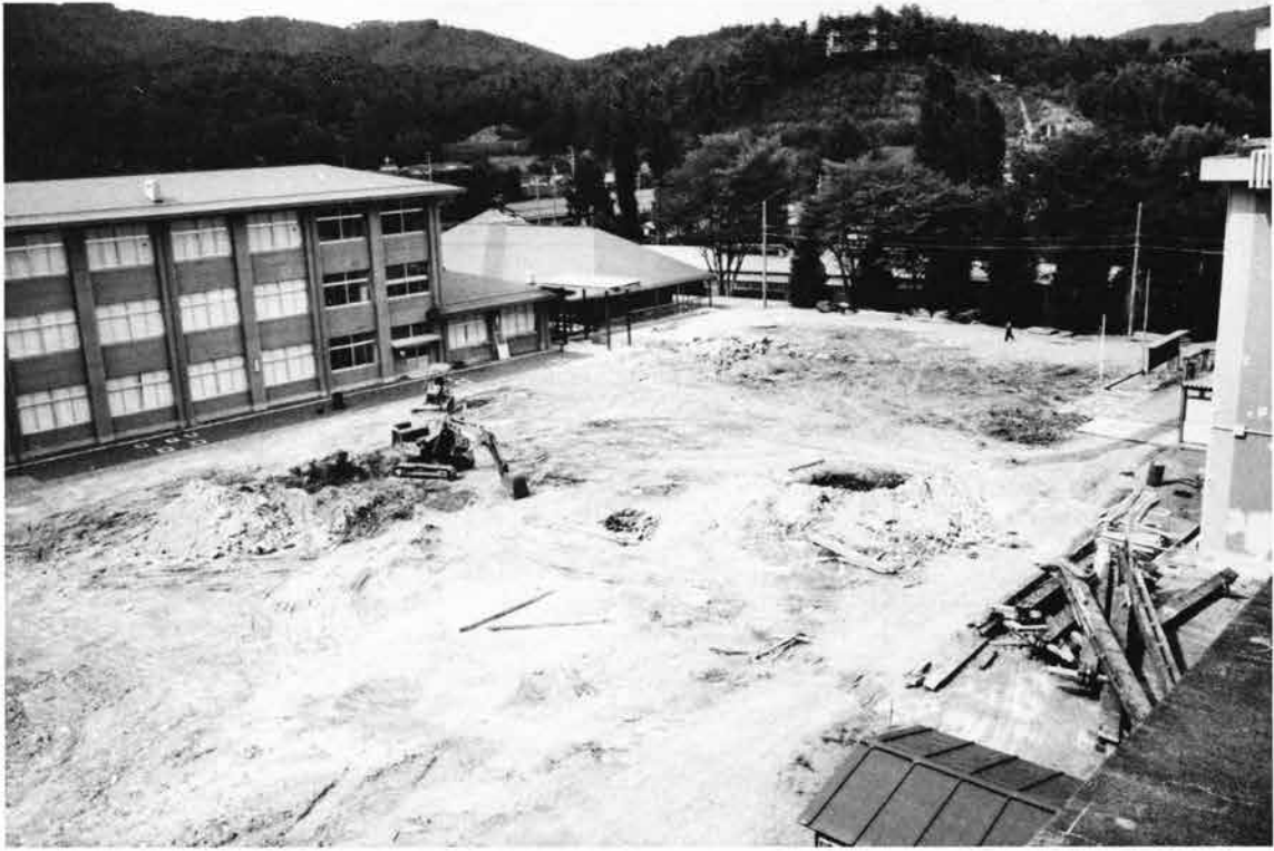
(1) A・Bトレンチ調査地全景（南西から）
