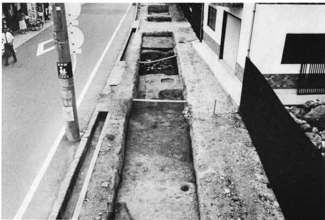
(1) Vトレンチ全景 (東から)
