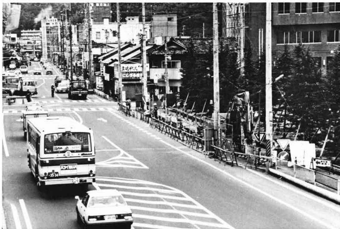
(1) 調査地遠景 (南西から)
