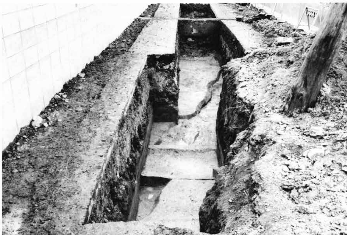
(1) B・Cトレンチ全体 (西から)
