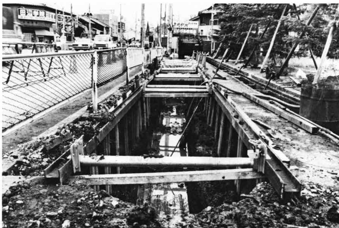
(2) トレンチ掘削状況 (南から)
