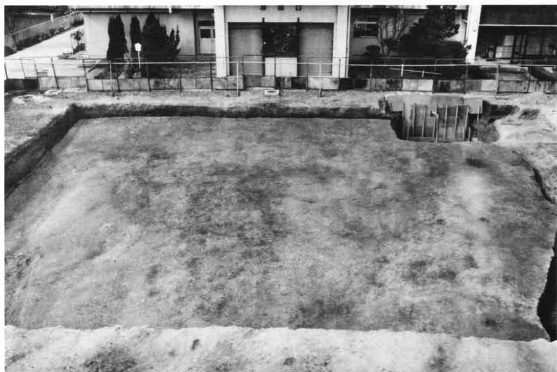
(2) 調査地全景（東から）
