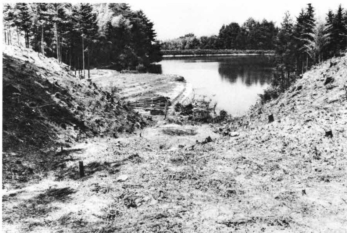
(1) 調査前近景 (南から)
