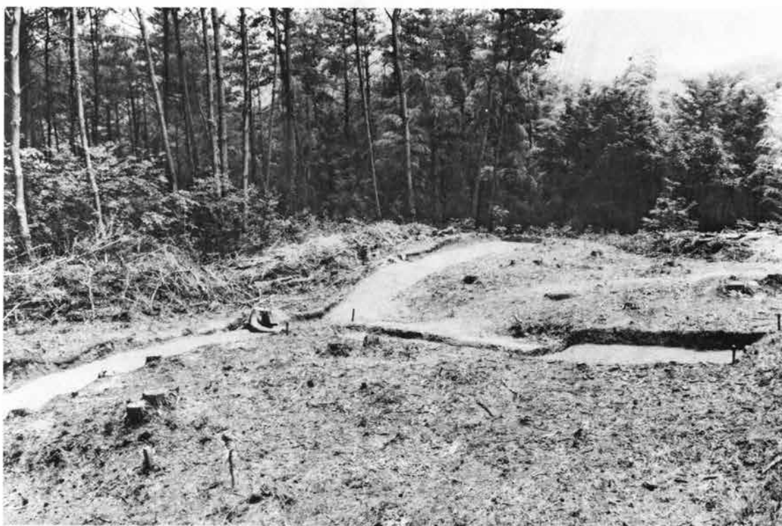
(2) トレンチ掘削状況(南西から)
