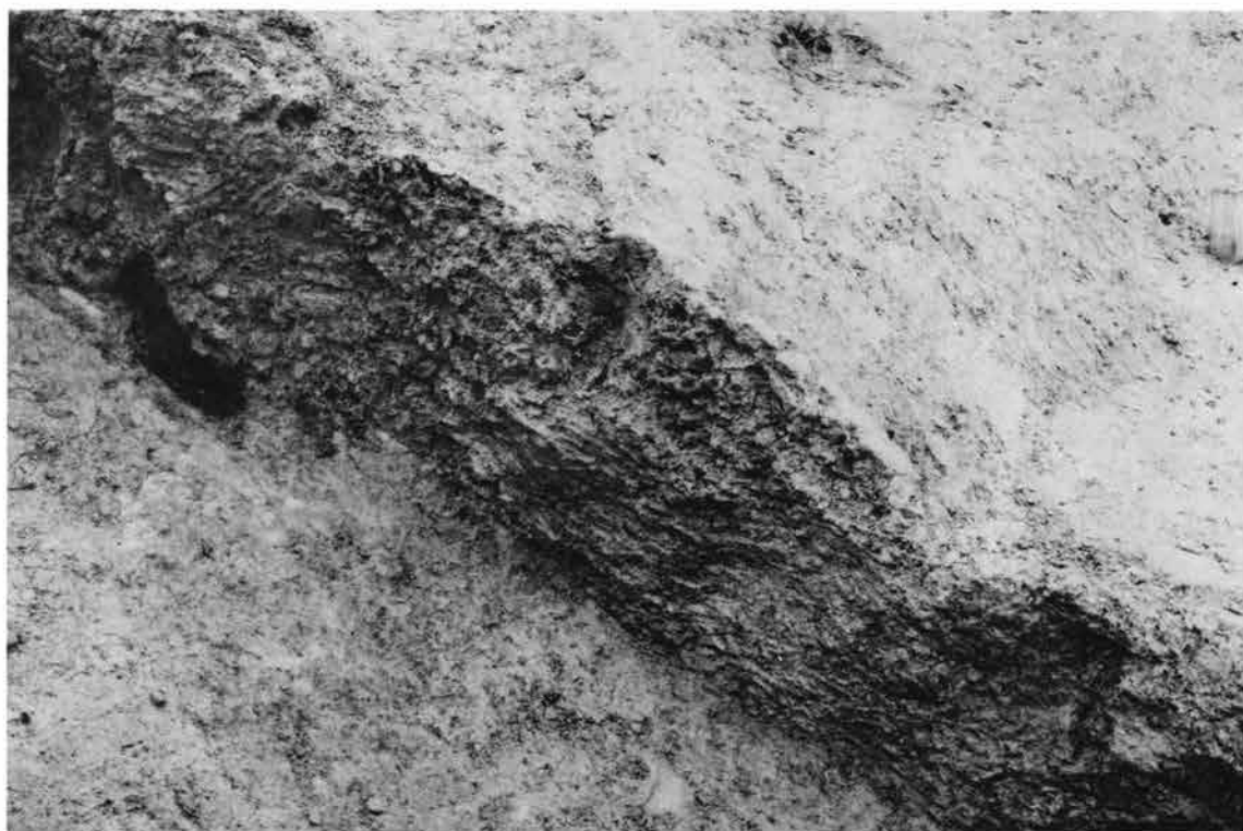
(2) 窯体壁面（北西から）
