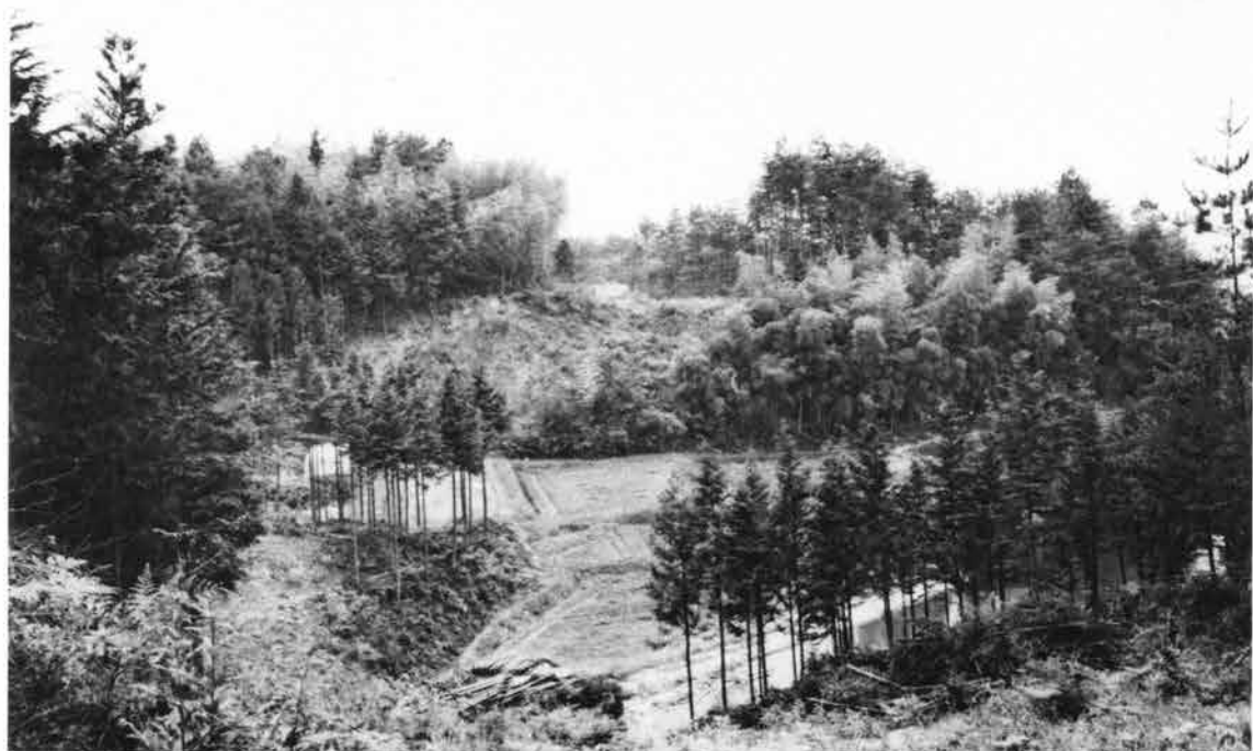
(1) B区調査地遠景(東から)
