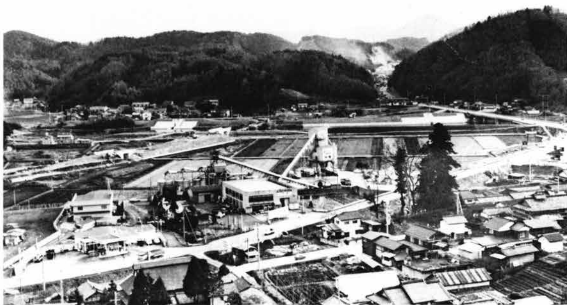
(1) 調査地遠景 (西北から)
