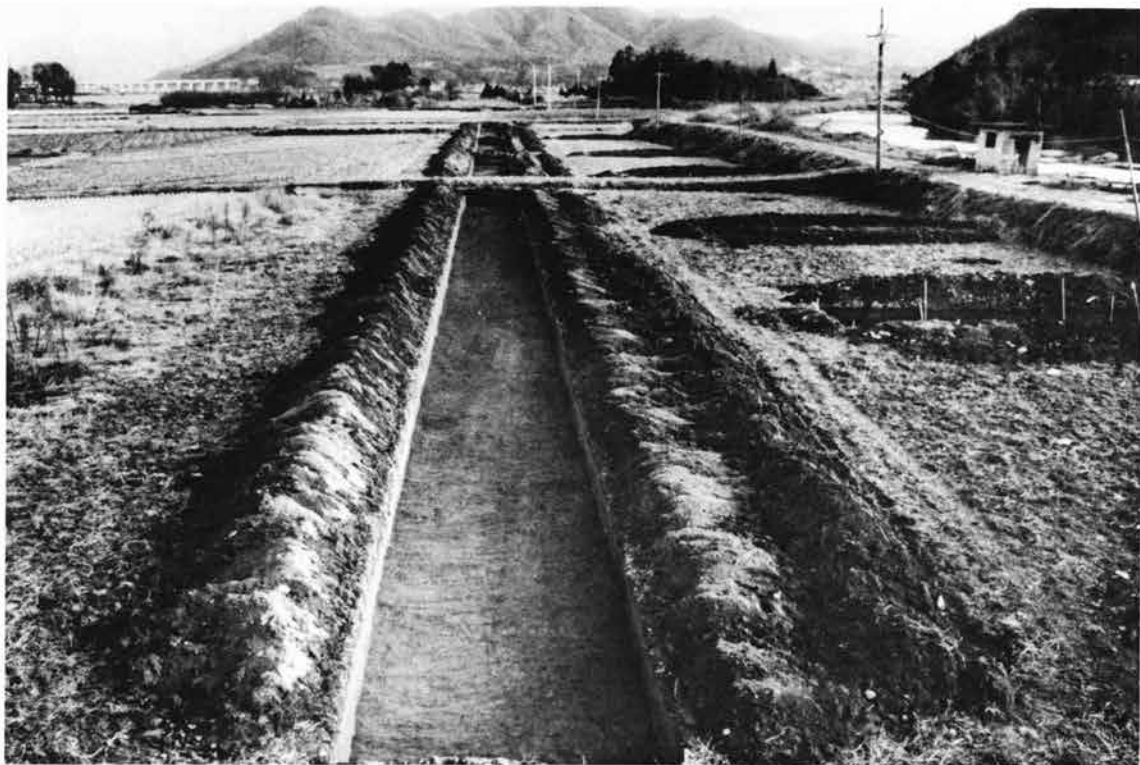
(1) トレンチ掘削状況（北西から）
