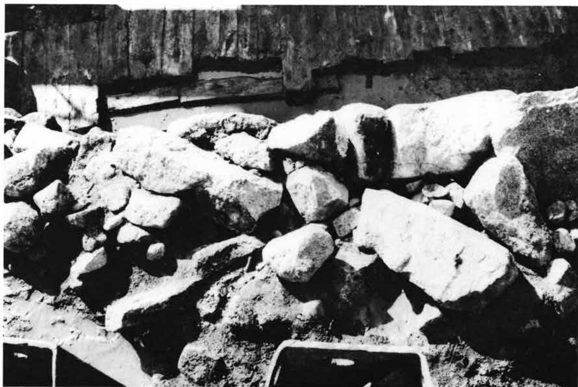
(1) 新・旧石垣接続部
