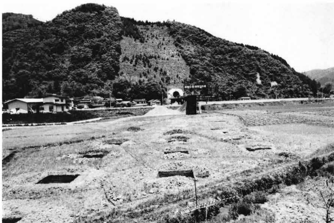
(1) 試掘調査状況（南から）
