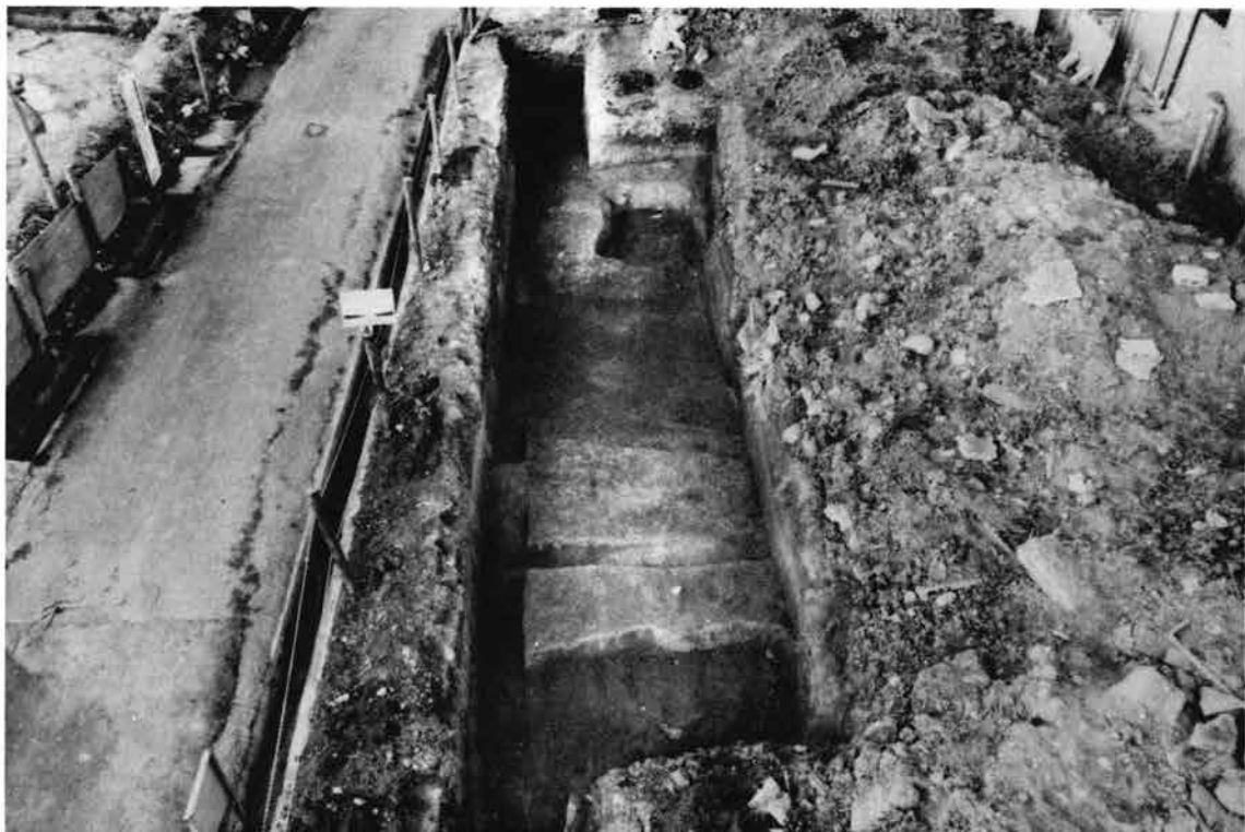
(1) Gトレンチ全景 (南から)
