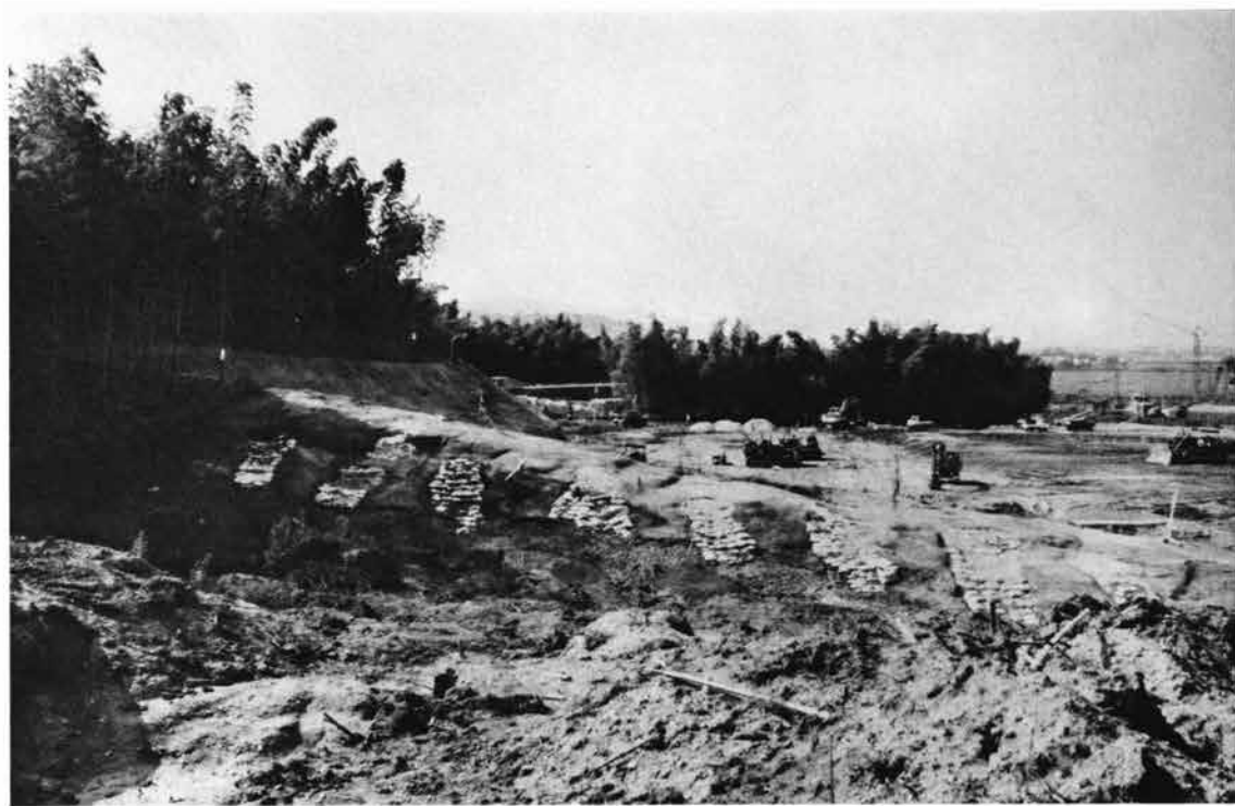
(2) 横穴群保存作業風景
