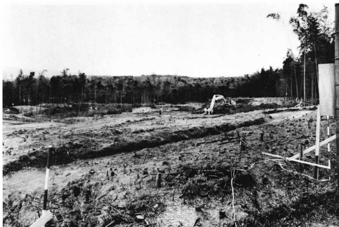
(2) B・C・D地区全景（北西から）
