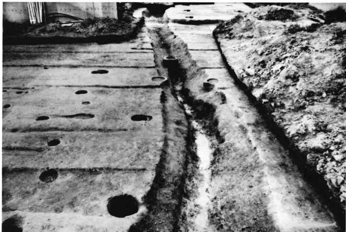
(1) EトレンチSD10550 (東から)
