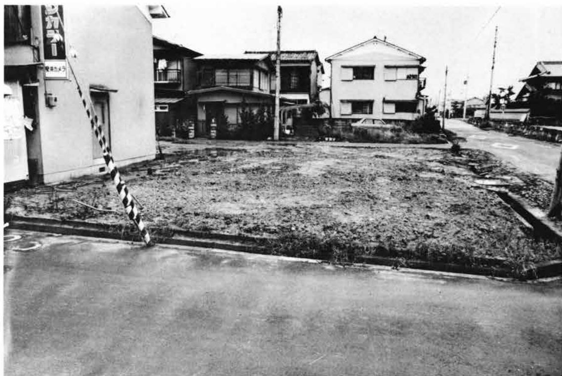
(1) 調査前全景 (南から)
