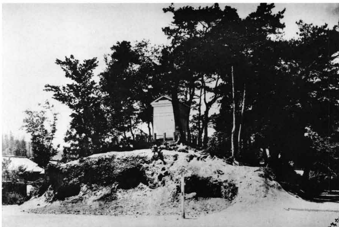
(2) 昭和10年6月撮影の「築山」(北東から)
