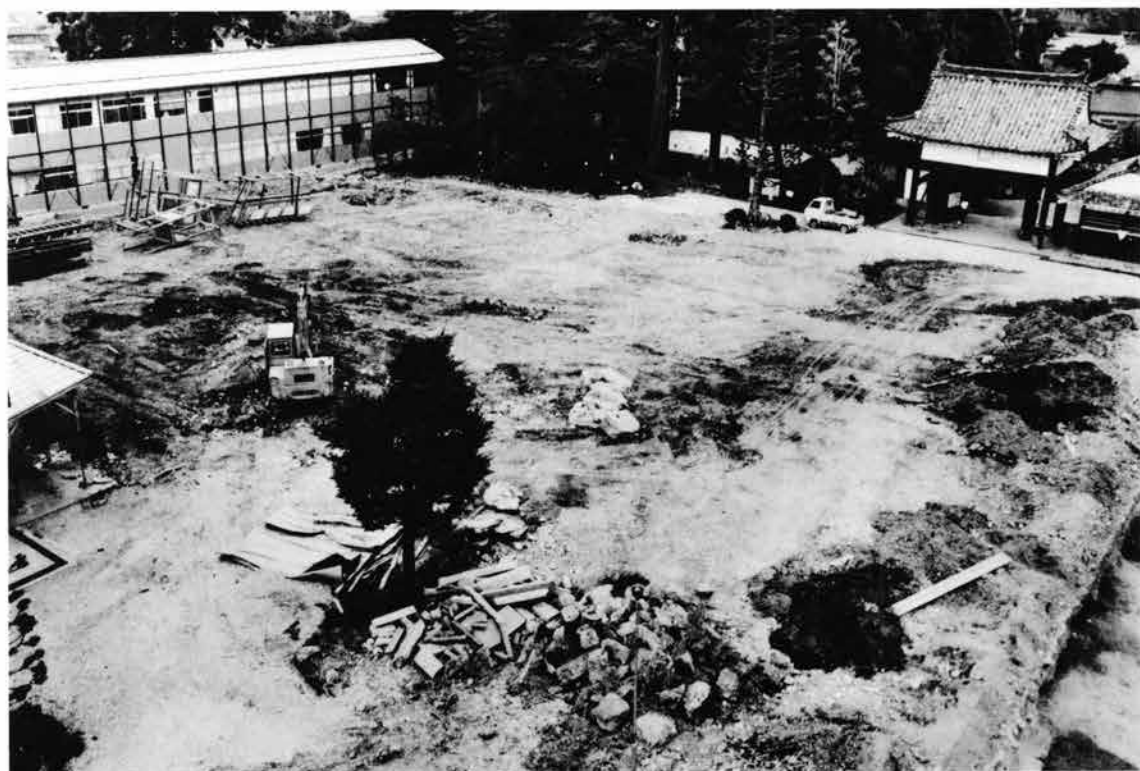
(1) 第2調査地調査前風景(西から)
