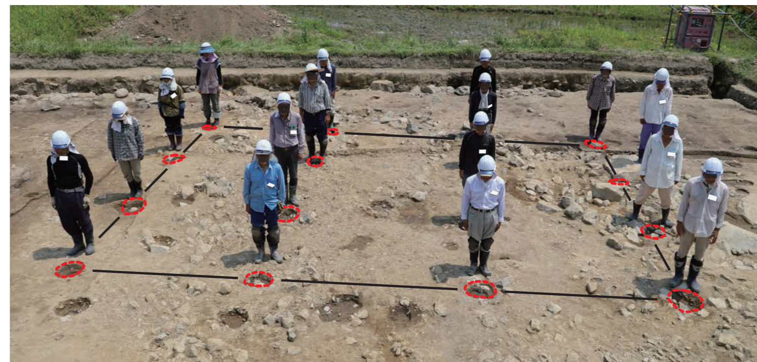
写真1 掘立柱建物2検出状況(西方向から) ※赤い破線で囲んでいる部分が柱穴です。
