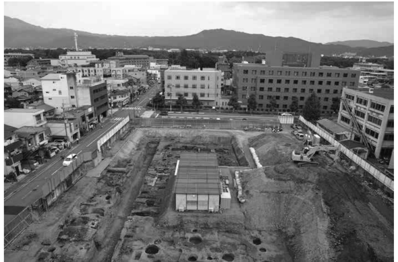
写真1 調査地全景 (西から)
