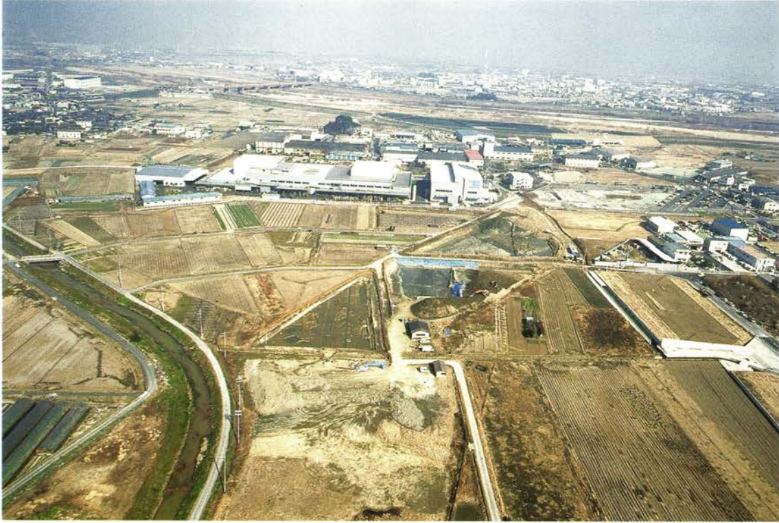
(1) D 地区遠景(南から)
