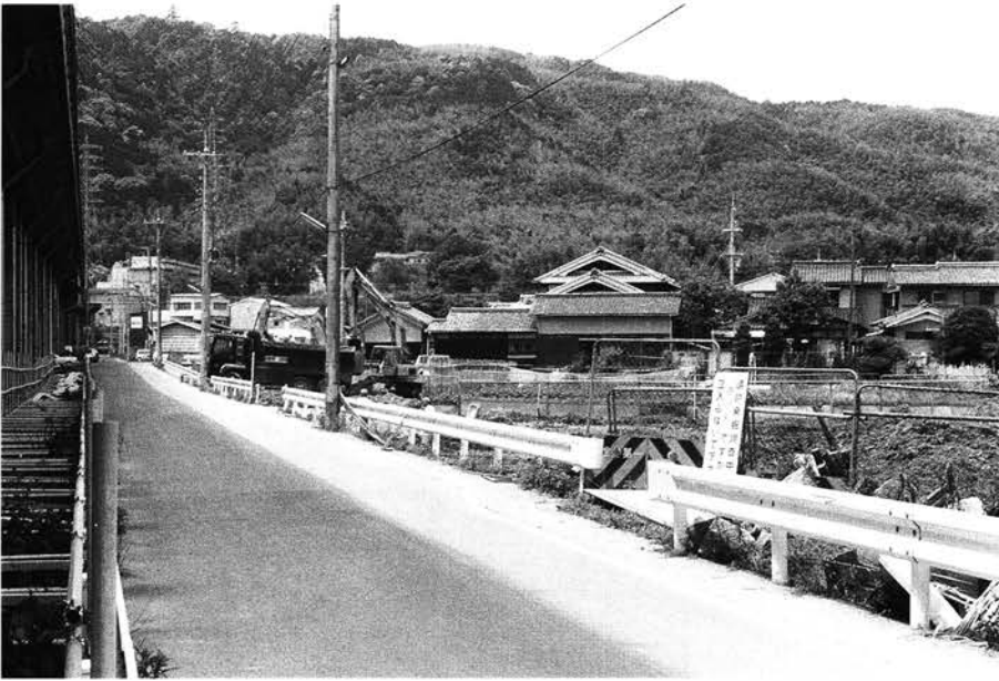
(1)D 地区調査着手前全景 (東から)
