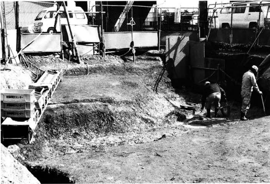
(1)C 1 トレンチ S R34901掘削状況(西から)
