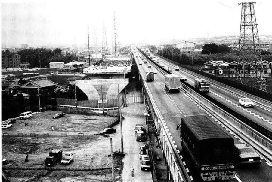
(3)D地区拡幅工事の状況 (西から)
